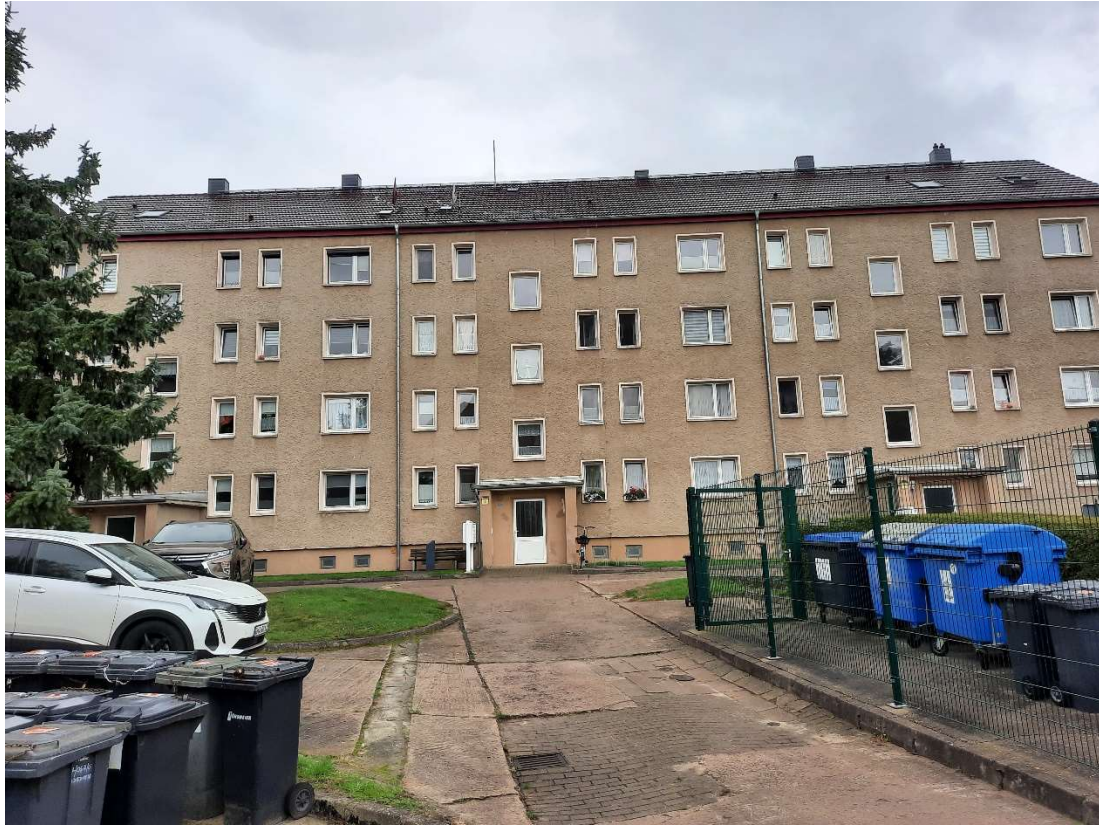
Abbildung 22 | Mehrfamilienhaus um 1960 mit erneuerter Dacheindeckung
