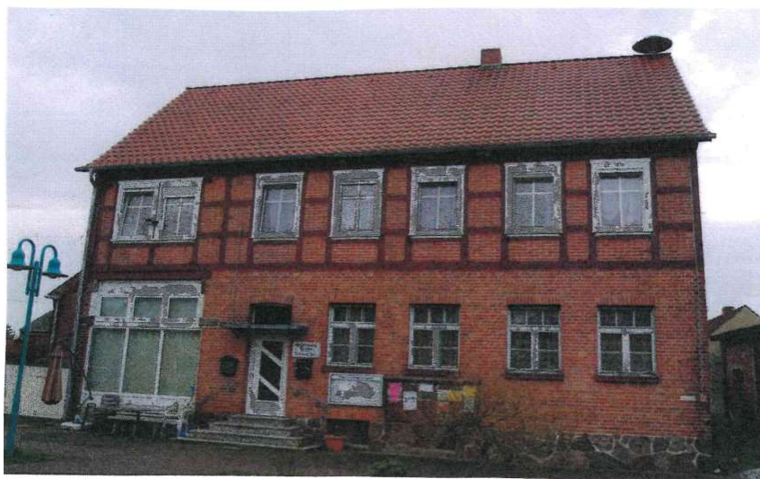
Abbildung 17 | freistehendes Fachwerkhaus (Baujahr vor 1918)
