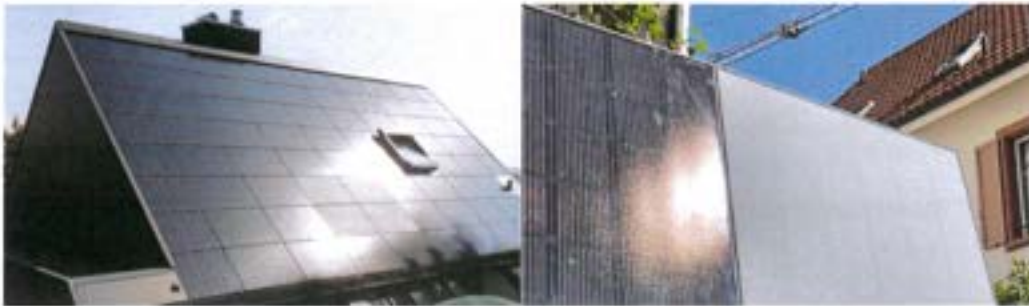
Abbildung 9: links: Module mit satinierter Folie (Bucher 2021), rechts: nachträglich sandgestrahltes Modul (Warthmann 2021)
