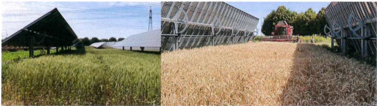
Wachstum und Abreife des Getreidebestandes vom EWS-Sonnenfeld in Bruck an der Leitha [ https://www.ews-sonnenfeld.com/referenzprojekte/detail/ews-sonnenfeld-bruck-an-der-leitha ]
