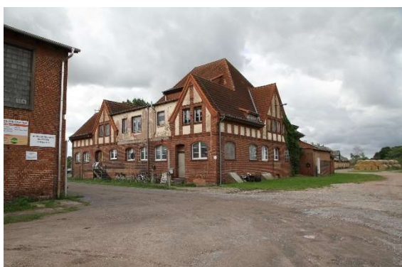
Gewerbebetrieb und Tierhaltungsanlage südlich des Geltungsbereichs
