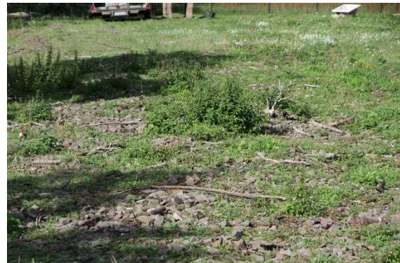
Gleisbettreste (Schotter) im östlichen Bereich
