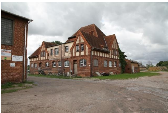
Gewerbebetrieb und Tierhaltungsanlage südlich des Geltungsbereichs
