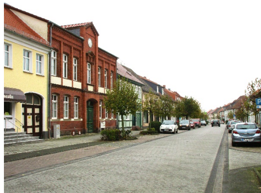
Abbildung 5: Friedensstraße nach der Sanierung
