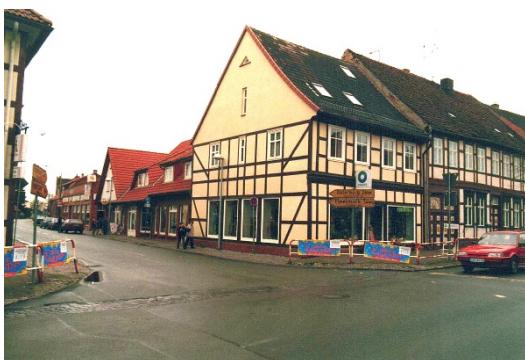
Abbildung 6: Friedensstraße Einmündung Bahnhofstraße vor der Sanierung
