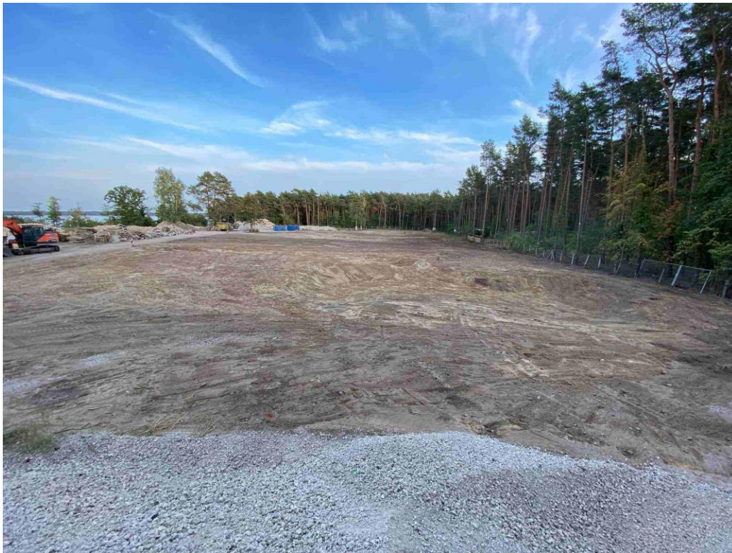
zentraler Bereich des Resorts nach erfolgtem Abriss, Stand Dezember 2020
